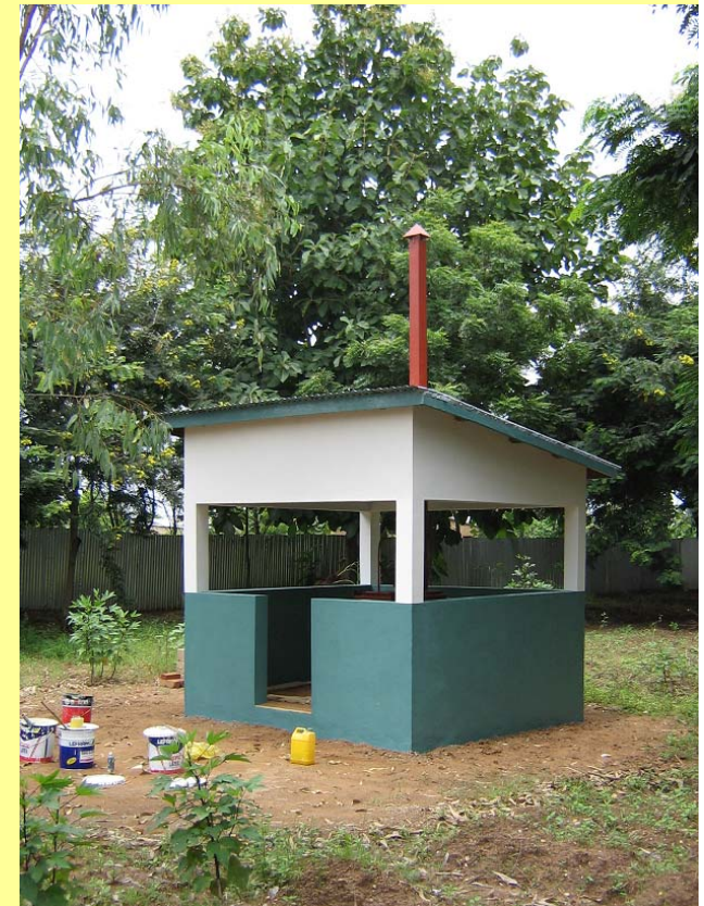
Vb Verbrandingsoven Door SAB gebouwd in Boukombé
